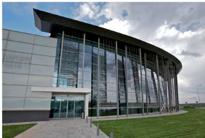
FABRICATION PLANT 1 FLA Fiorenzuola d'Arda - Piacenza
